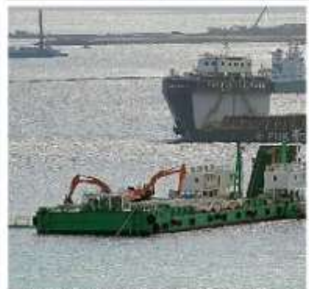
辺野古沖の大浦湾で、船上の2台の重機から石材が海中に投入された＝10日午後1時18分、沖縄県名護市、櫻橋映月撮影
