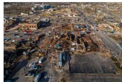
米南部ケンタッキー州メイフィールドの中心部で11日、竜巻によって倒壊した建物=AP
