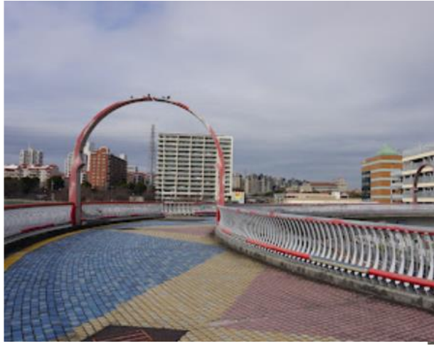
南大沢輪舞歩道橋
